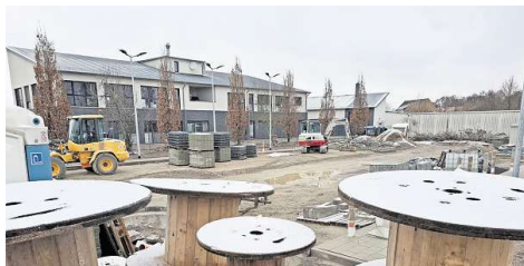
Reichlich Leitungen sind nötig: Leere Kabeltrommeln liegen auf der Baustelle an der Kokenhorststraße.
